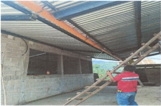
Foto 2: Colocación de canal
