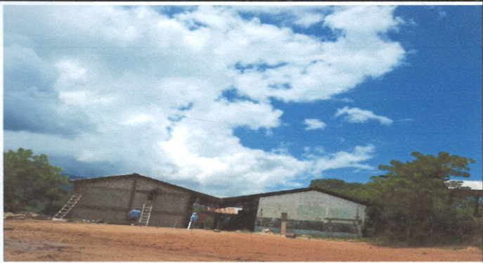
Foto1: Finalización de entechado del modulo
