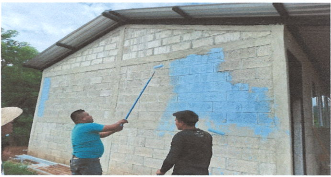
Foto 4: Inicio de pintado de paredes
