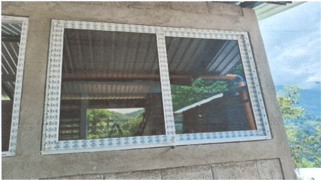
Foto 3: Instalación de ventanas
